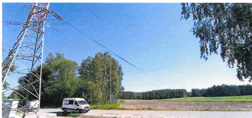
Przęsło 46 - 45 linii 110 kV RS Kity w kierunku GPZ Wysokie Mazowieckie
