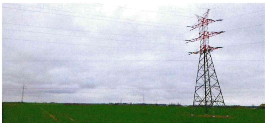
Przęsło 32A – 1 linii 110 kV Wysokie Mazowieckie – Łapy
